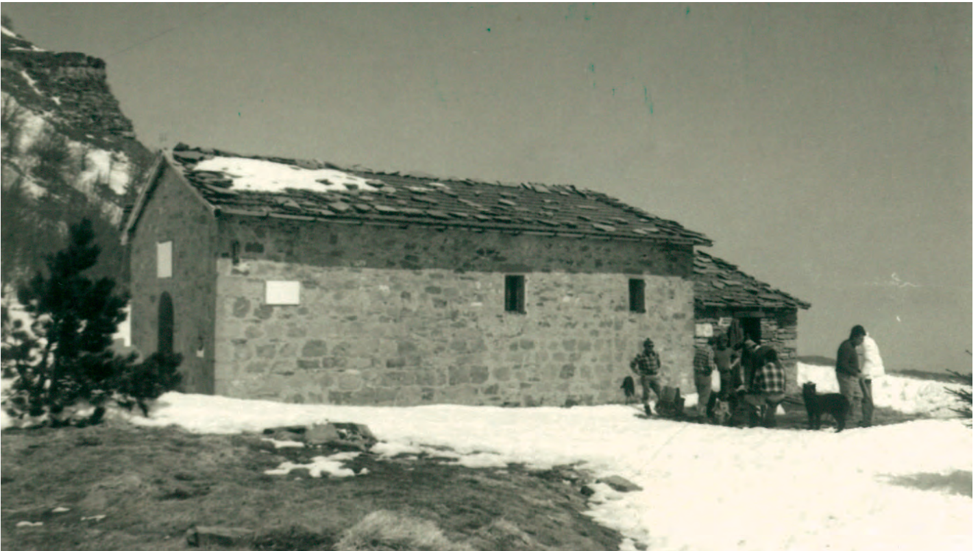
13 aprile 1980. Sopralluogo all'oratorio di Santa Maria Maddalena
